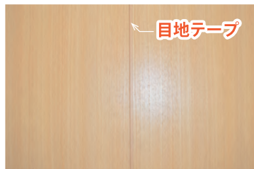
目透かし施工で美しく仕上がります!
